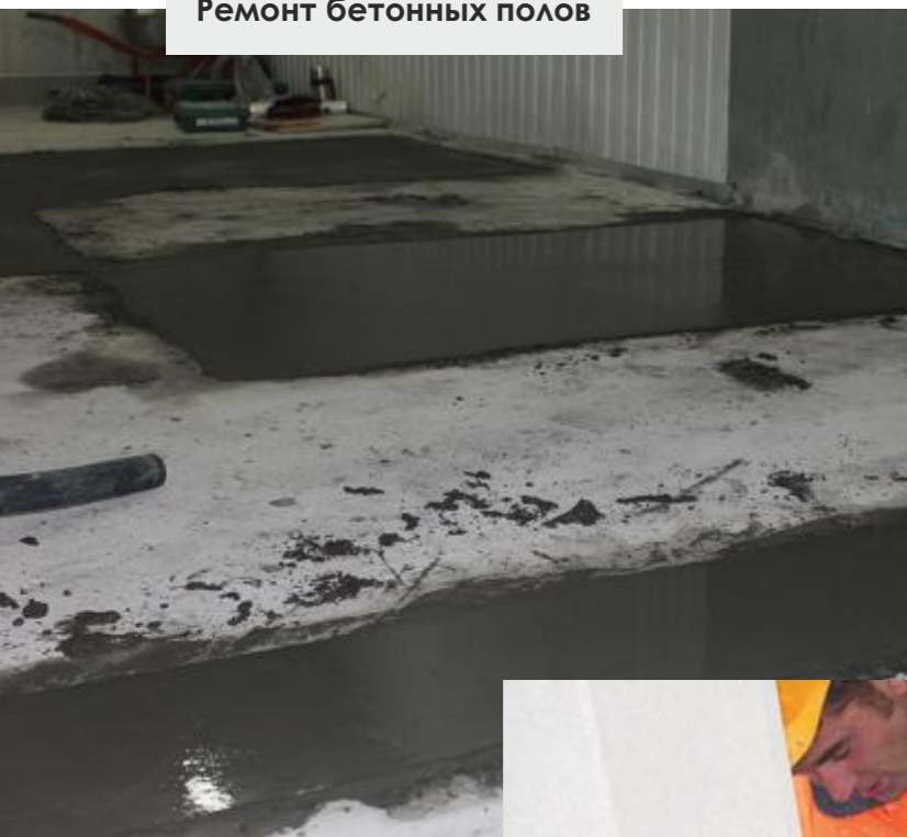
Ремонт бетонных полов
