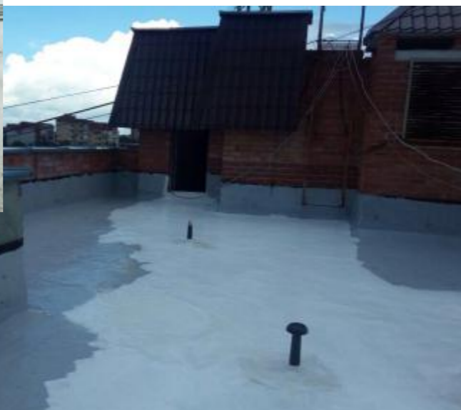
Гидроизоляция кровли
